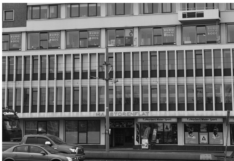
Flatgebouw naast de Erasmusbrug.
